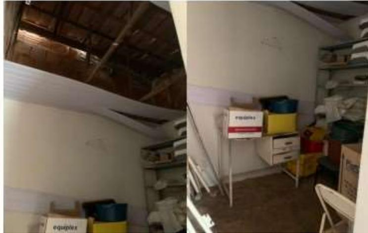
**Figura XII:** Abertura na parede da sala de dispensação de medicamentos, causando entrada de insetos, poeira e água da chuva.
