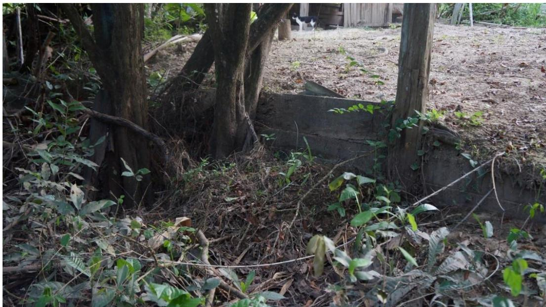
Figura 9 - Aterro do Sr. Zé da Barra. Contenção do aterro - toco de cerne e pranchão.
