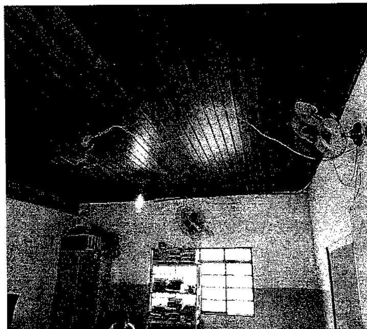
Cabos, fios e interruptores elétricos soltos.
