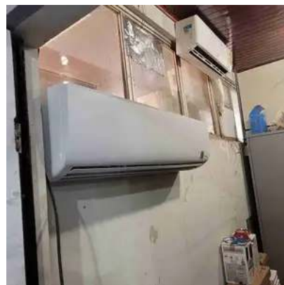
Serviço de manutenção preventiva
