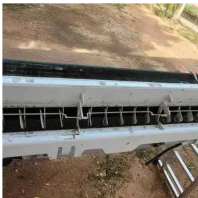
Serviço de manutenção preventiva
