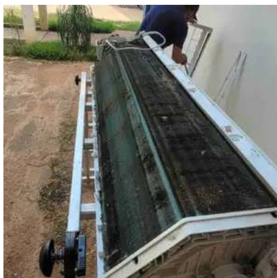
Serviço de manutenção preventiva
