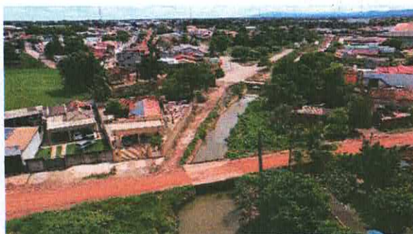
Foto 03-Final do trecho canalizado revestido em concreto
