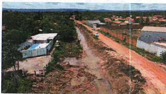
Foto 15-Trecho do canal próximo ao deságue.
