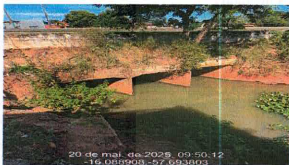
Foto 09 - Bueiro de BTCC a montante
