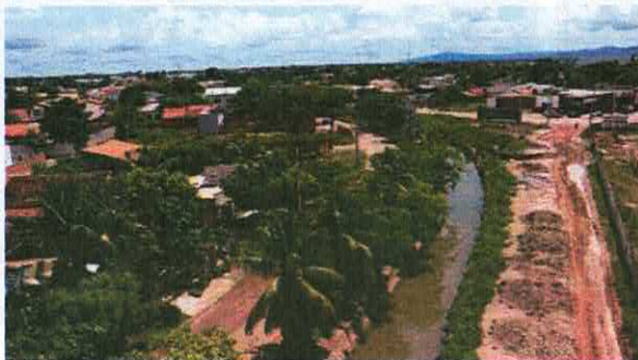
Foto 01- Trecho canalizado revestido em concreto
