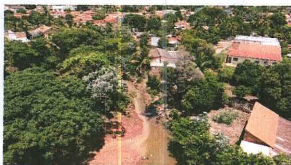
Foto 12-Trecho do canal em solo natural
