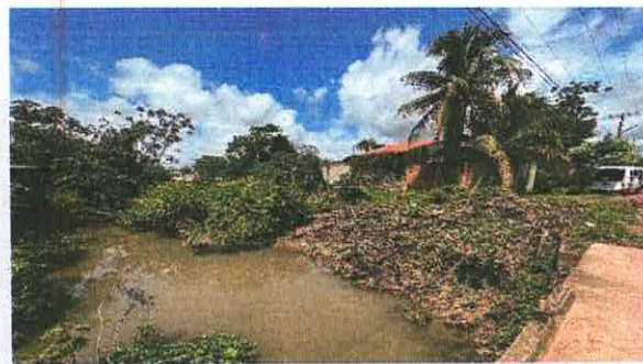
Foto 04- Trecho do canal em solo natural
