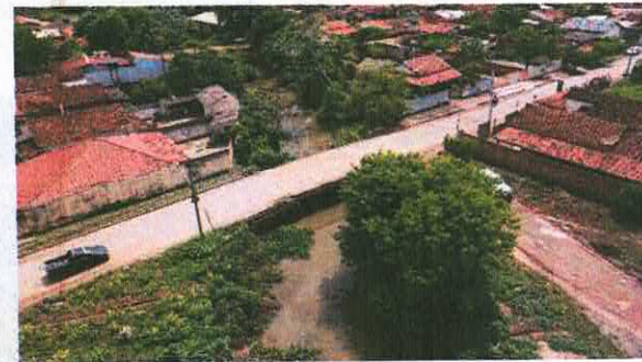
Foto 06-Trecho do canal em solo natural
