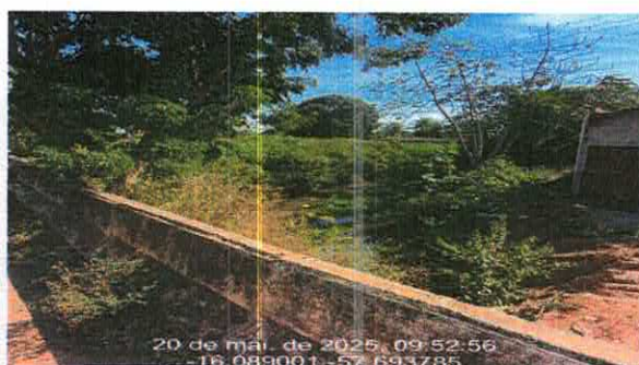
Foto 10 - Bueiro de BTCC a montante
