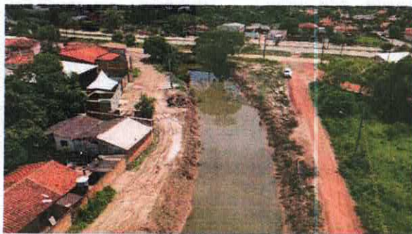
Foto 11-Vista do BTCC a jusante
