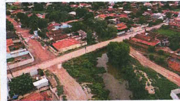
Foto 08-Trecho do canal em solo natural
