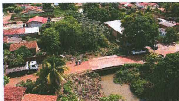
Foto 05-Trecho do canal em solo natural
