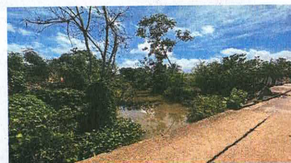
Foto 07-Trecho do canal em solo natural
