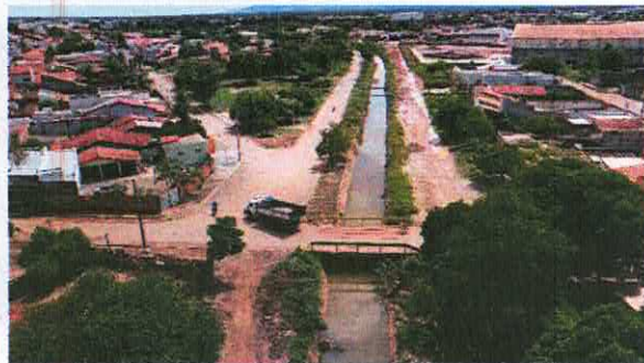
Foto 02- Trecho canalizado revestido em concreto
