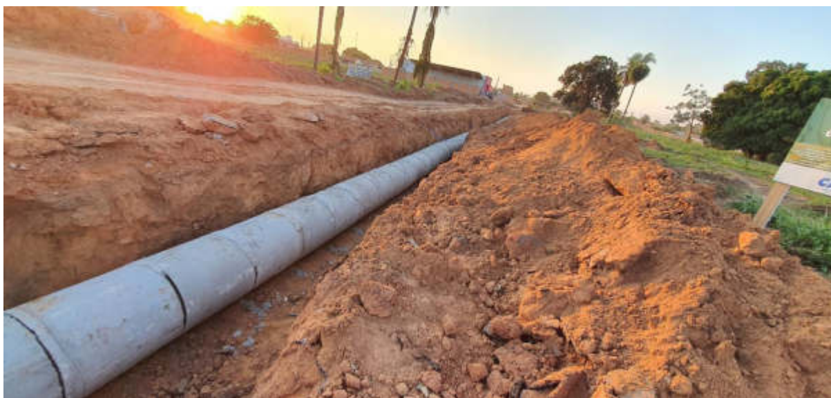
Figura 6 - Av. dos Estados: T2-Tubulação
