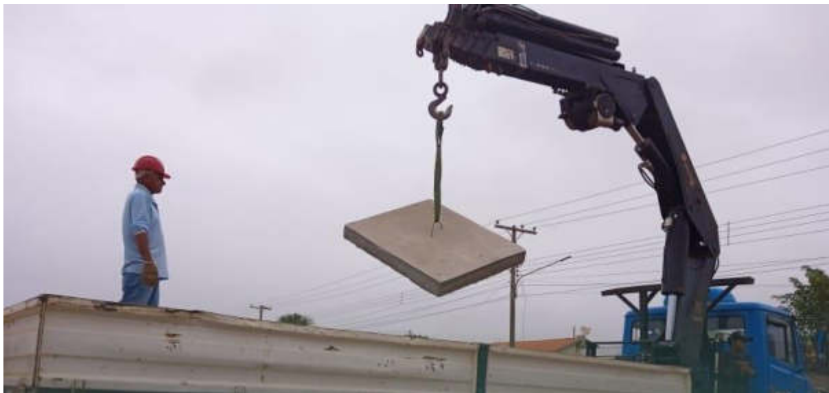
Figura 15 - Transporte de Material
