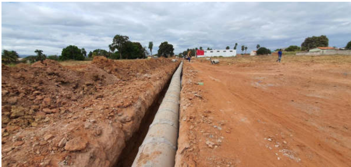
Figura 5 - Av. dos Estados: T3-Tubulação
