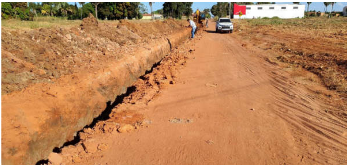
Figura 4 - Av dos Estados: T3-Escavação
