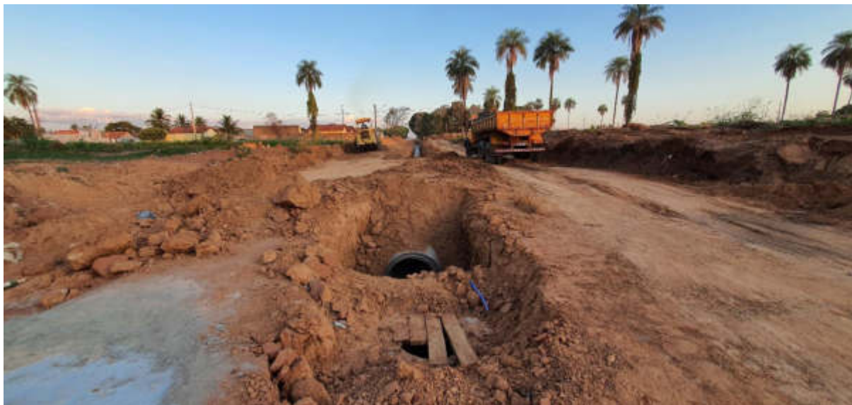
Figura 7 - Av. dos Estados; PV-3 e Aterro T2
