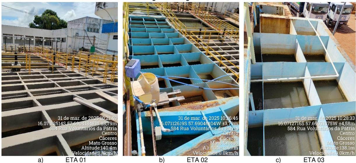
Cada ETA compreende unidades de mistura rápida, floculação e decantação. A água decantada das três ETAs converge para um único sistema de filtração (seis filtros). A ausência de macromedicação na saída da água tratada impede a quantificação de perdas nos blocos de tratamento.
