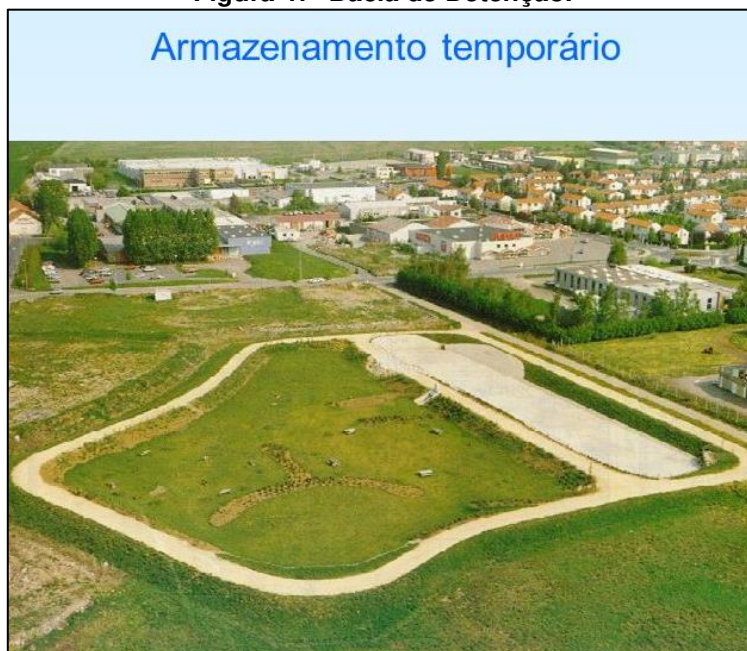
Figura 47- Bacia de Detenção.
