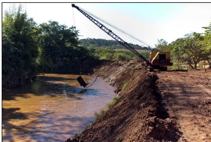
Figura 48- Exemplo de Alargamento e Desassoreamento.
