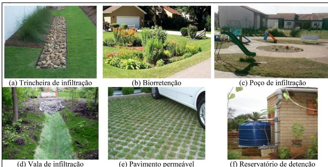
Figura 58- Exemplos de Controles na Fonte.
