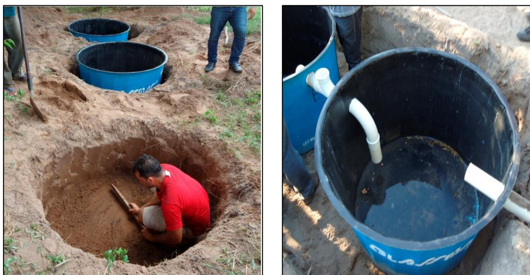
Figura 7: Exemplo de instalação da fossa biodigestor.
