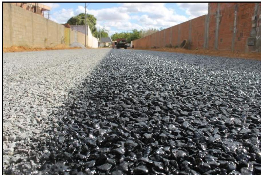
Imagem: Banho de ligação em camada de agregado
