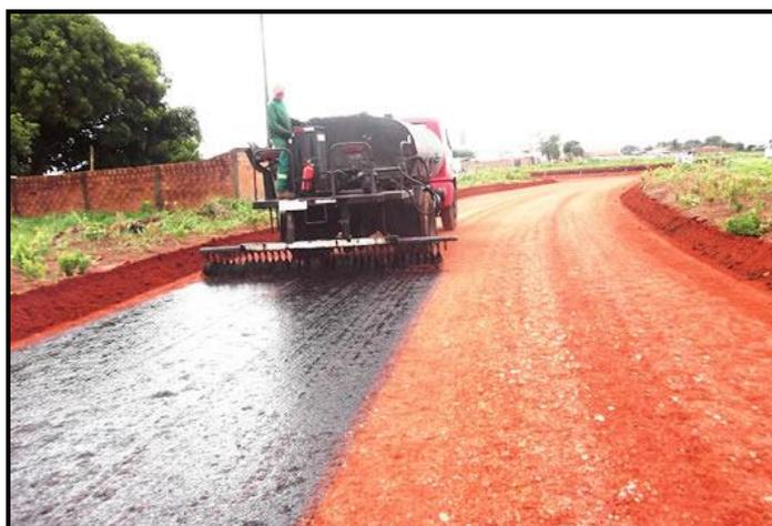
Imagem: Imprimação em base com asfalto diluído CM-30
