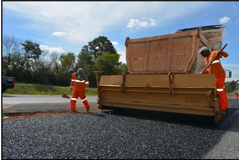
Imagem: Aplicação da 2ª camada de agregado
