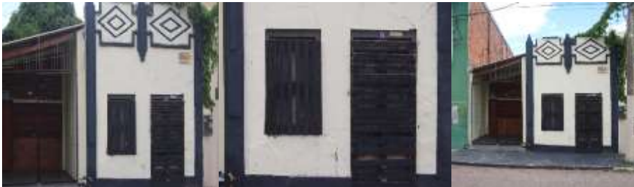
Casa Sebastião – pintada e limpa.
