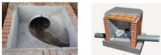
Figura 2 e 3 – Fundo das caixas de inspeção
