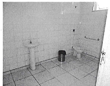
Banheiro feminino Recepção
