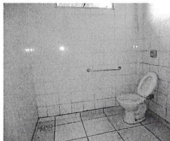
Banheiro masculino Recepção
