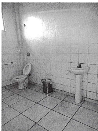
Banheiro masculino Recepção
