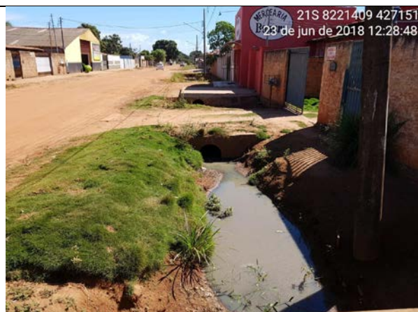
Detalhe da vala de drenagem e dos bueiros nas entradas dos comércios e residências.
