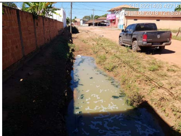
Cadastramento da valeta de drenagem na Rua do Membeca próximo ao cruzamento com a Av. Talhamares
