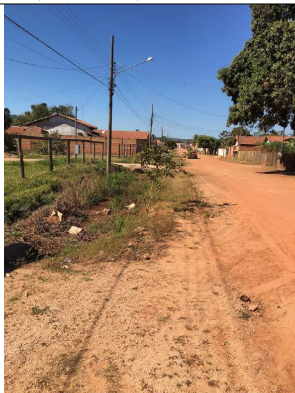
Vista panorâmica da Rua do Membeca, com detalhe para pontos de alagamento na lateral da via onde existe uma vala para drenagem a céu-aberto.
