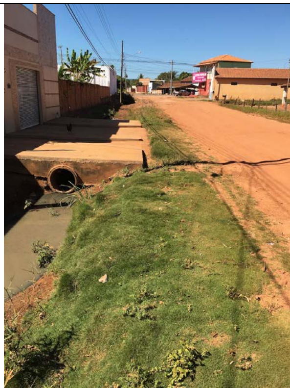
Pontos de passagem de águas em entrada de residência. Valeta para escoamento superficial na Rua do Membeca
