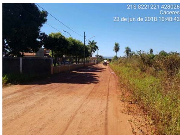
Cadastramento de poste de energia, muro e vala de drenagem em frente ao SESC.
