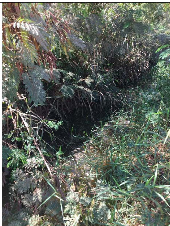
Detalhe da entrada do bueiro que cruza a Av. Getúlio Vargas
