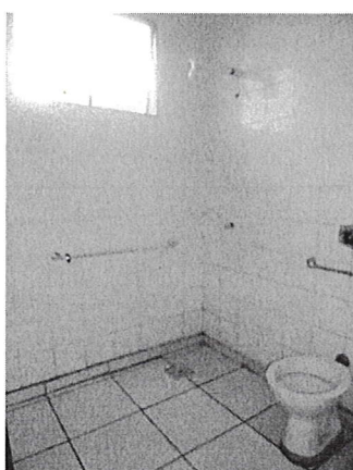
Banheiro Enfermaria Feminina
