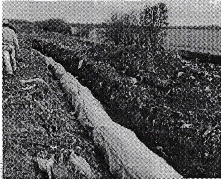
Figura 7: Instalação de drenagem do chorume para elevação do patamar do aterro sanitário.
